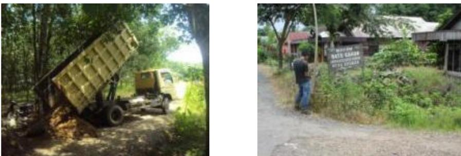
*Gambar 63. Bantuan material sirtu/pasir batu untuk pengerasan jalan tani Datu Ganum di Desa Tatakan*
