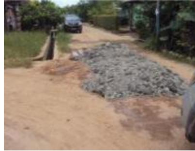
*Gambar 64. Bantuan sirtu untuk pengerasan jalan komplek Asabri rantau*
